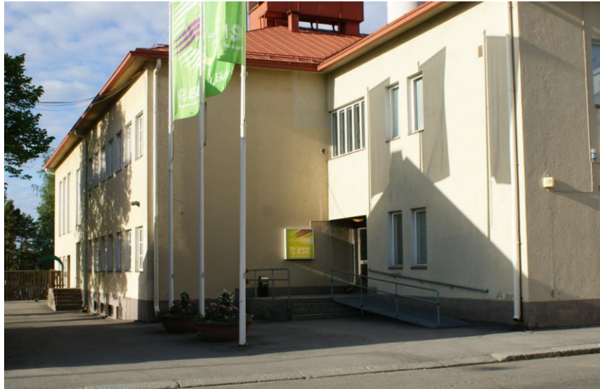
Kuva: Vuorikadun puoleinen fasadi ja sisäänvedetty pääsisäänkäynti.
