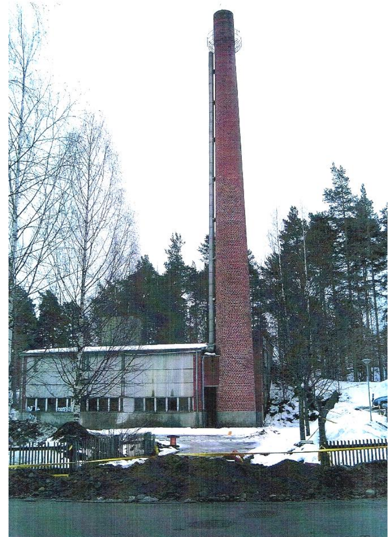
Kuva: Vuonna 1978 Kiiskinlämpö Oy lakkautettiin ja yhdistettiin pääverkkoon lämmönsiirtimellä. Vuonna 1995 Kiiskinmäen lämpökeskus jäi pois käytöstä ja kattila siirrettiin Oravinmäen lämpökeskukseksi Olavi Räsänen Oy:n tehdasalueelle. Kiiskinmäen lämpökeskus ja sen tiilipiippu on sittemmin purettu ja tilalle rakennettu kerrostalo. / ESEN valokuvat.
