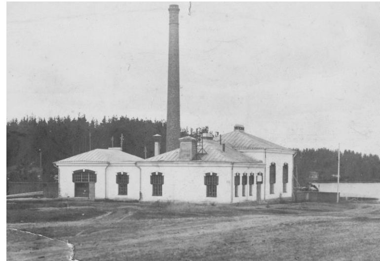
Kuva: Sähkölaitos vuosina 1913 ja 1915 tehtyjen laajennusten jälkeisessä asussa 1920-luvulla. / Suur-Savon museo, T. Wirilanderin kokoelma.
