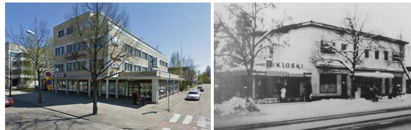
Kuva: Savon Voiman konttori, 1973. Pieksämäen sähkölaitoksen vanha toimitalo, toimisto ja myymälä, Keskuskatu 13:ssa on purettu (oikealla).
