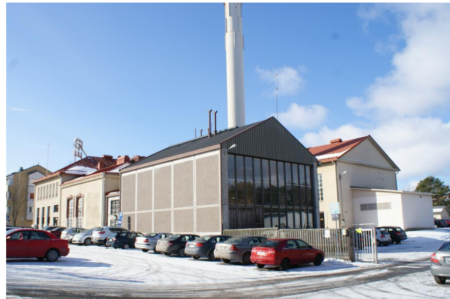
Kuva: 1970-luvun lämpökeskus ja piippu ovat rakennuksen nuorinta kerrostumaa.
