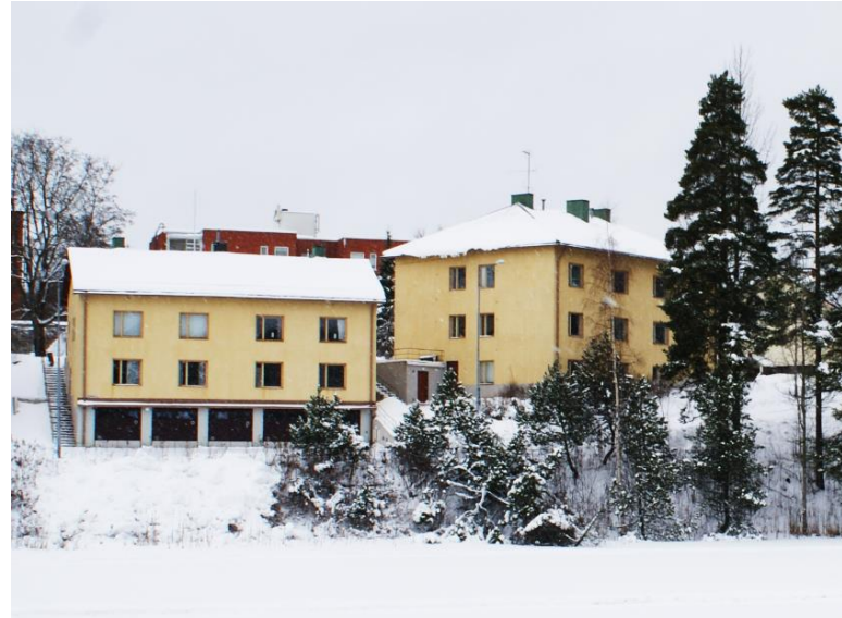
Kuva: Yrjönkatu 22 sijaitsee Myrkkylammen länsirannalla.
